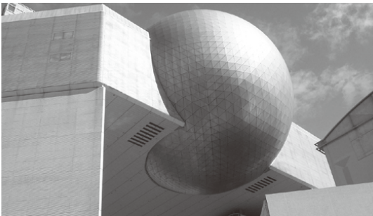
日立シビックセンター外観
